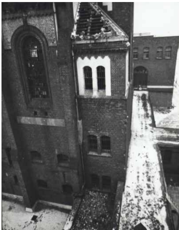
Fotografia nr 6. Spalony dach jednego z pawilonów mieszkalnych.
